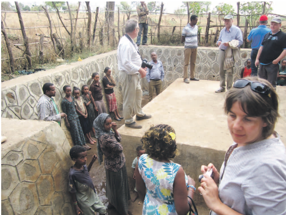
■ Betonilla suojattu lähde Pawe Woredan kylässä. Kuvassa etualalla tohtori Mikaela Kruskopf. Betonikannella valkoisessa paidassaan kamera kaulassa Tapio Niemi.
